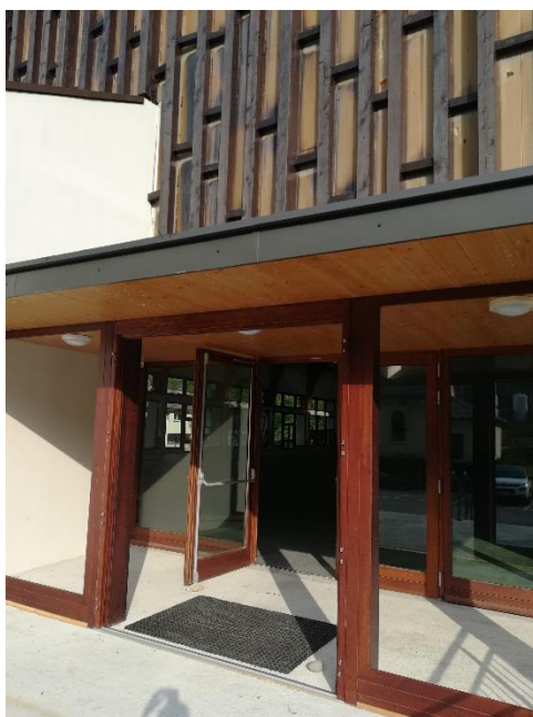
Entrée du gymnase
