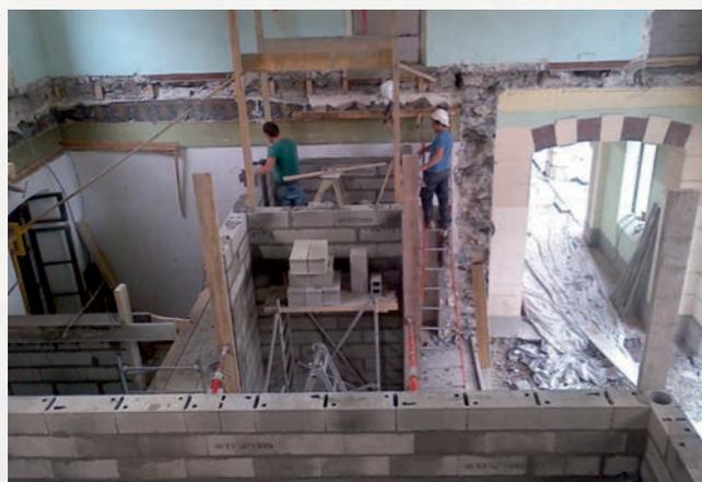
Réalisation des murs porteurs de l'escalier (en bas de la photo) et de la cage d'ascenseur (au milieu de la photo)
