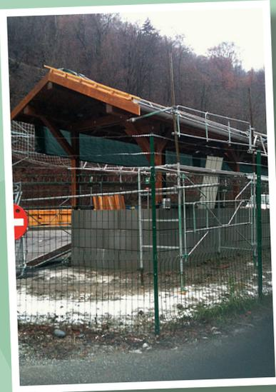
Les travaux ont démarré fin novembre avec l'entreprise COLAS, qui a réalisé les travaux de terrassement, de fondations et d'enrobé, puis se sont poursuivis avec la pose de la charpente par l'entreprise SECAF. Enfin l'entreprise FREDELEC a assuré la mise en place de l'éclairage.
