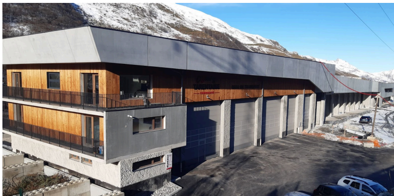
Figure 6 : Bâtiment administratif de la zone de la Planche en avant-plan
